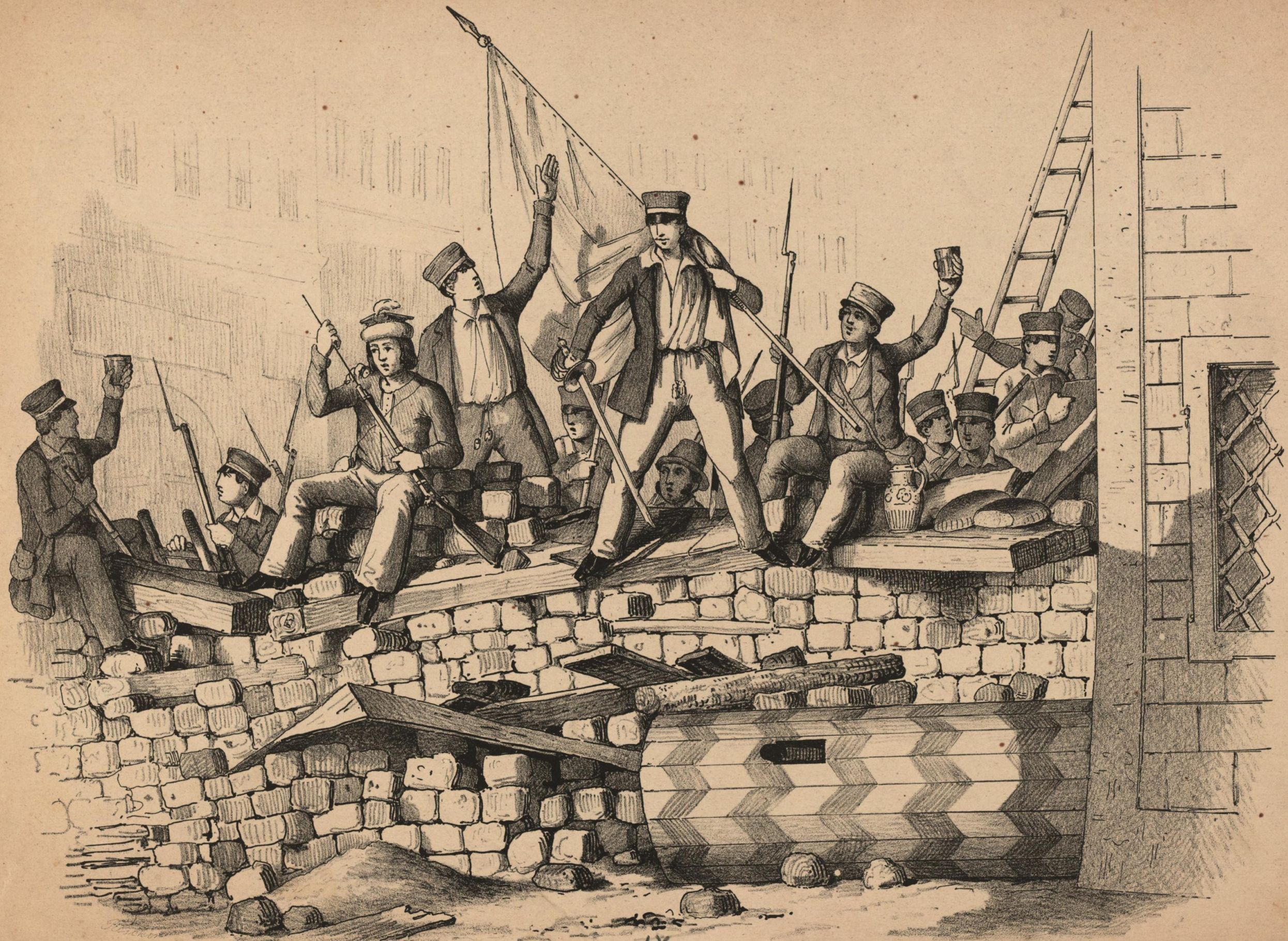
Barikáda u technického ústavu.
