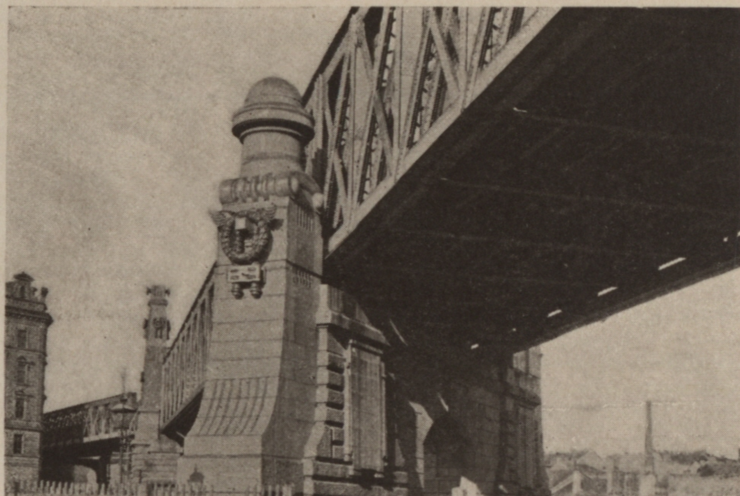
STADTBAHN: VIADUKT ÜBER DIE ZEILE.
