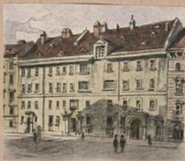
Das ehemalige alte Gebäude für Plastik, Malerei, Kunstgewerbe (Porzellanfabrik)
