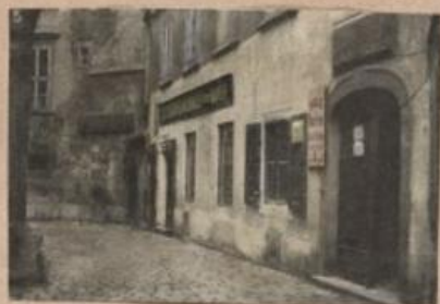
Das Haus Bollgasse Nr. 8 (Tischlerherberge) 1911
