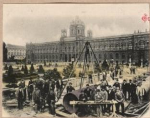
Gasrohrlegung 1200 mm für das neue Centralgaswerk der Commune Wien unter Bürgermeister Lueger.
