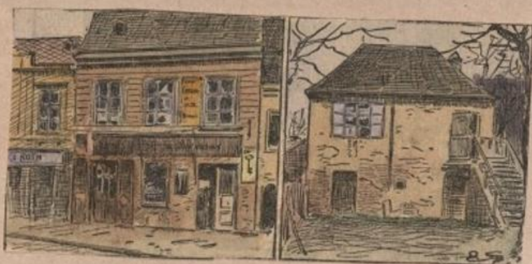
1912 Demolierung des Häuschen Josefstädterstrasse #45 an das sich Erinnerungen an Mozart knüpfen
