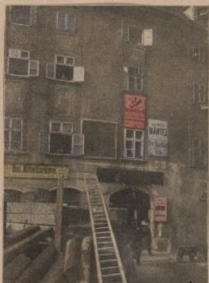
Ecke Steindlgasse und Rurrentgasse demoliert 1912
