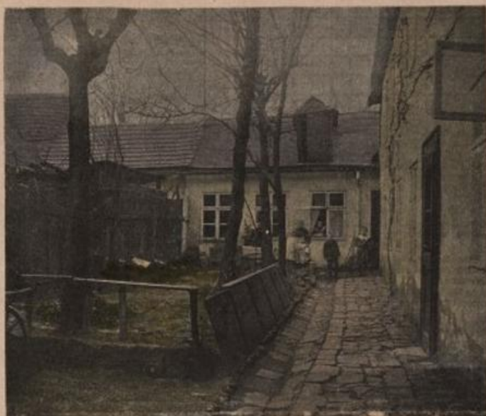
Demolirtes Eigenthum des Hofschauspieler's Kainz Eßlern 1900 Strozzigasse 21-23.
