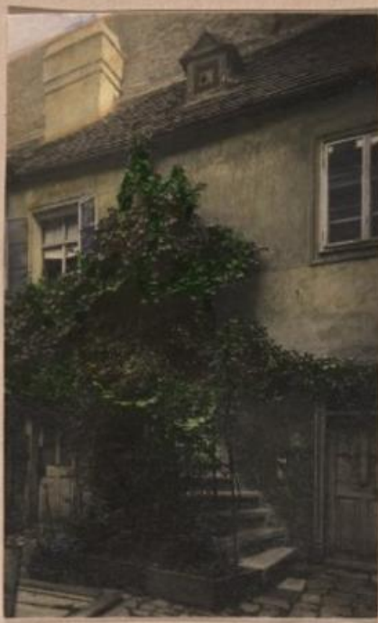
Hof im Mauerwerk WI Burg 1900
