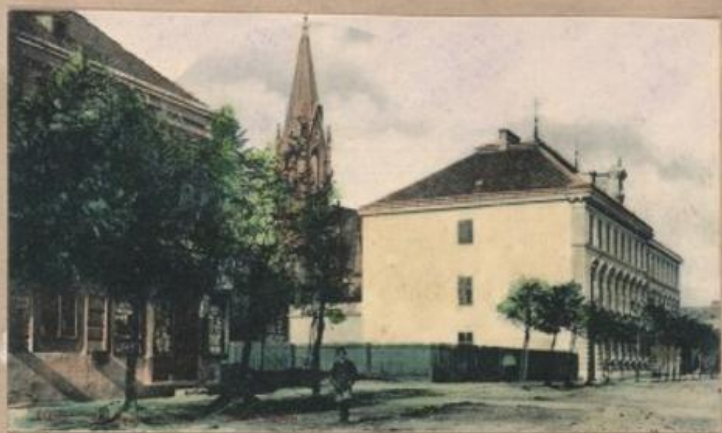
Alleggerstrasse mit Volksschule vor dem Zubau im Jahre 1898
