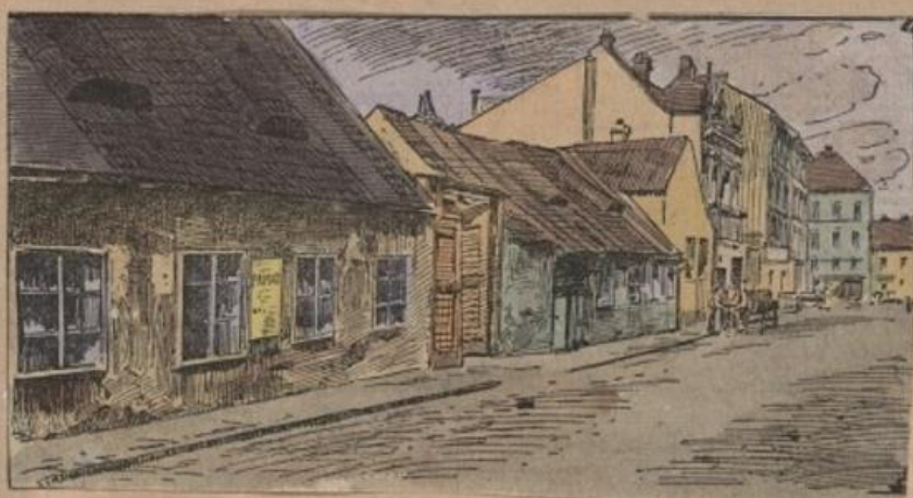
Der letzte Rest vom alten Nikolsdorf im V. Bz. Demolirt 1912
