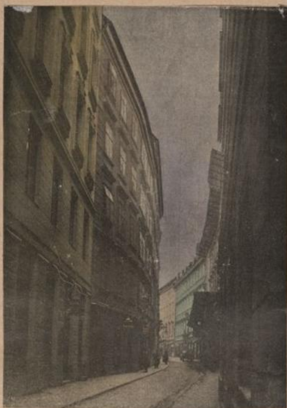
Ein Blick in die Dorothergasse, deren linke Häuserreihe demoliert wird 1912.
