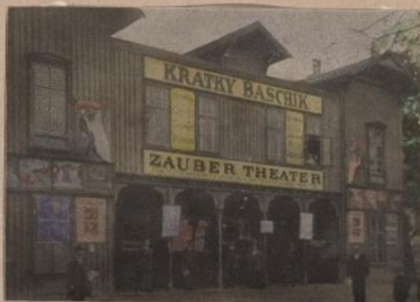
Kratky-Baschiks Zaubertheater im Prater demolirt 1912
