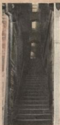
Die Wachtorgasse vom tiefen Graben aus gesehen 1911
