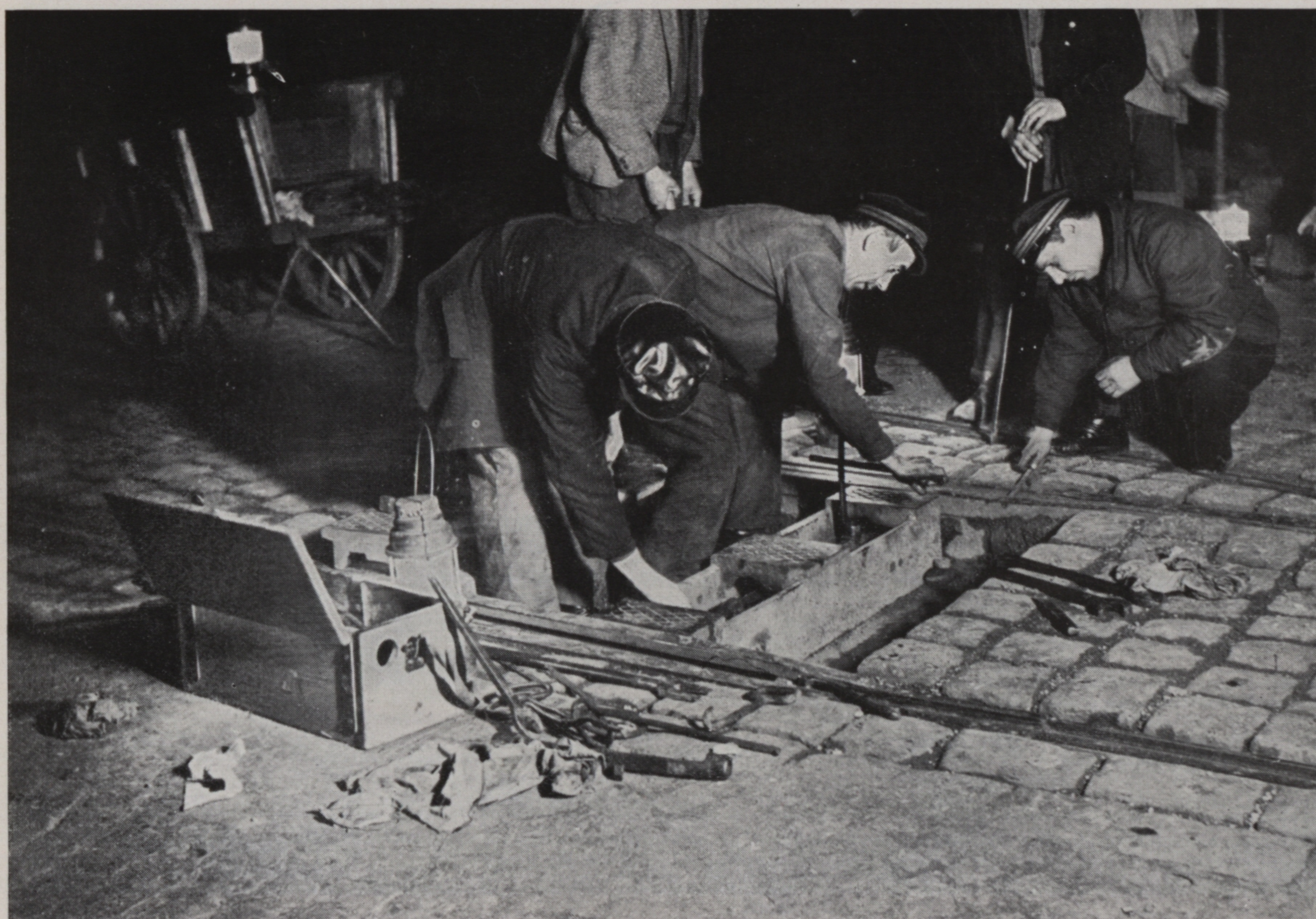
Weichenumstellung für das Rechtsfahren in der Nacht zum 19. September 1938.
