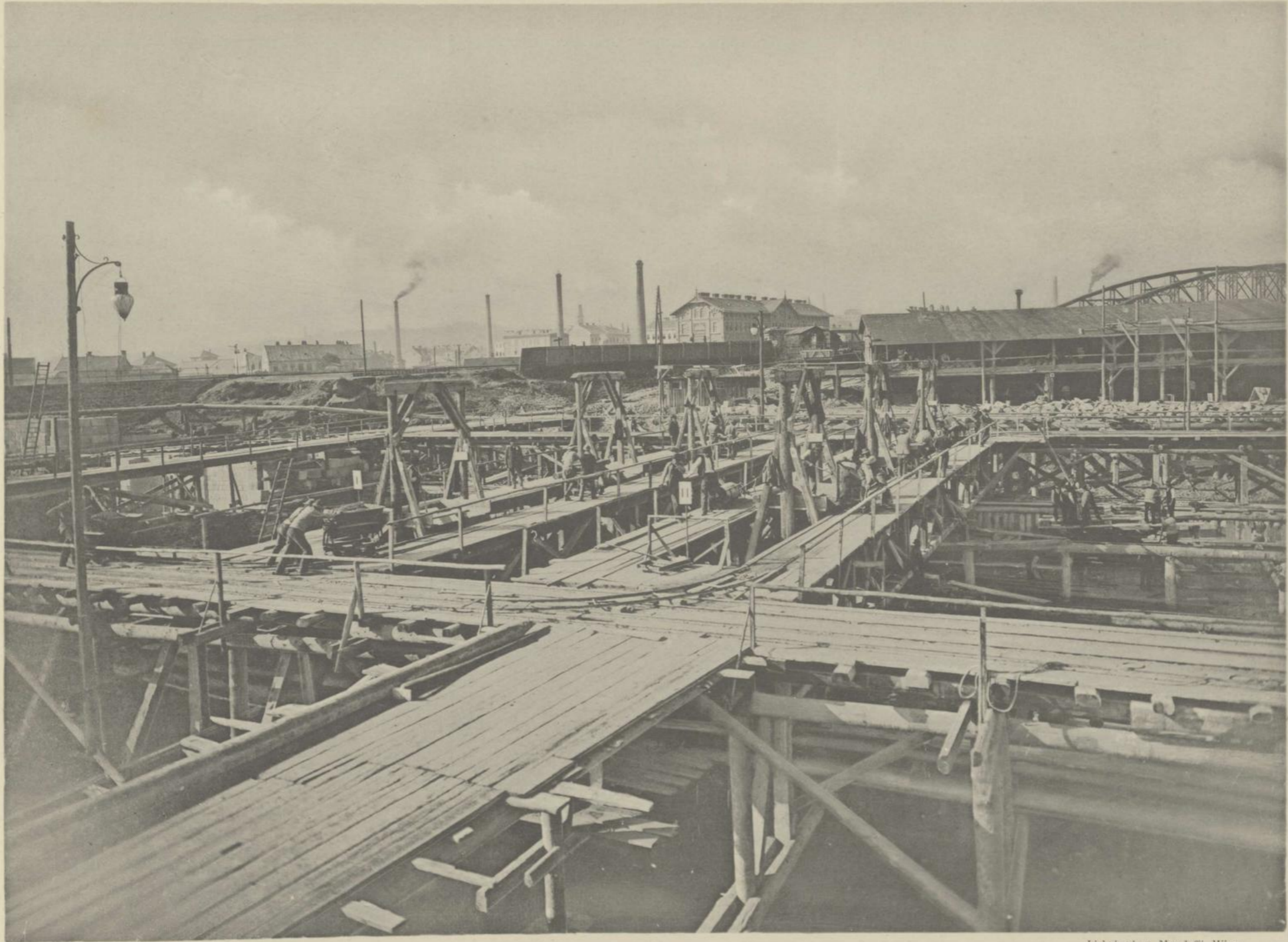
Betonirung der zweiten und dritten Schichte für die Sohle der Schleusenammer mit sechs Betontrichtern auf zwei Schiebebühnen. — Wasserstand 0.40 m unter Nullwasser.
