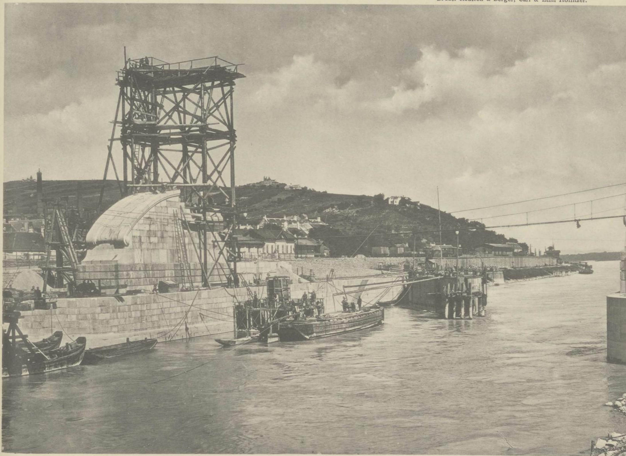
Aufbau des rechtseitigen Wehr-Widerlagers und Arbeitsstellung der Taucherglocke über der angrenzenden Caissonfuge. Wasserstand 0'93 m über Nullwasser.
