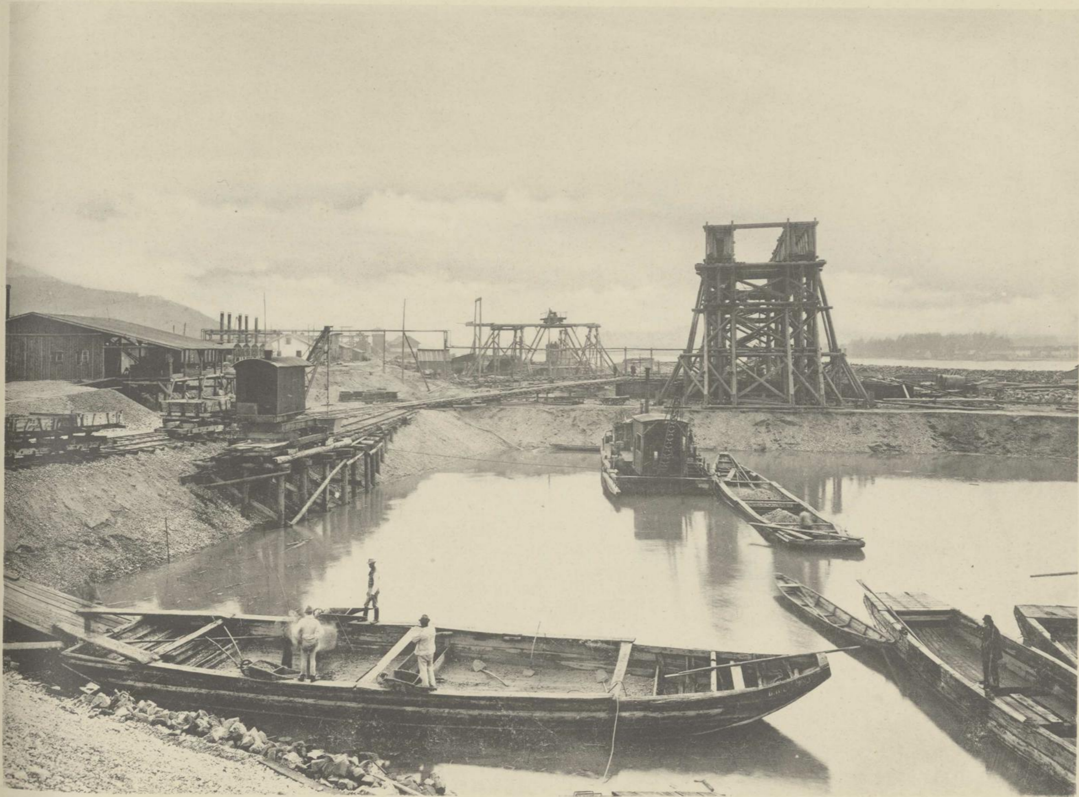
Baggerung im Mitteltheil der Kammerschleuse und Ausschleiben in den provisorischen Damm für die Donau-Uferbahn.
