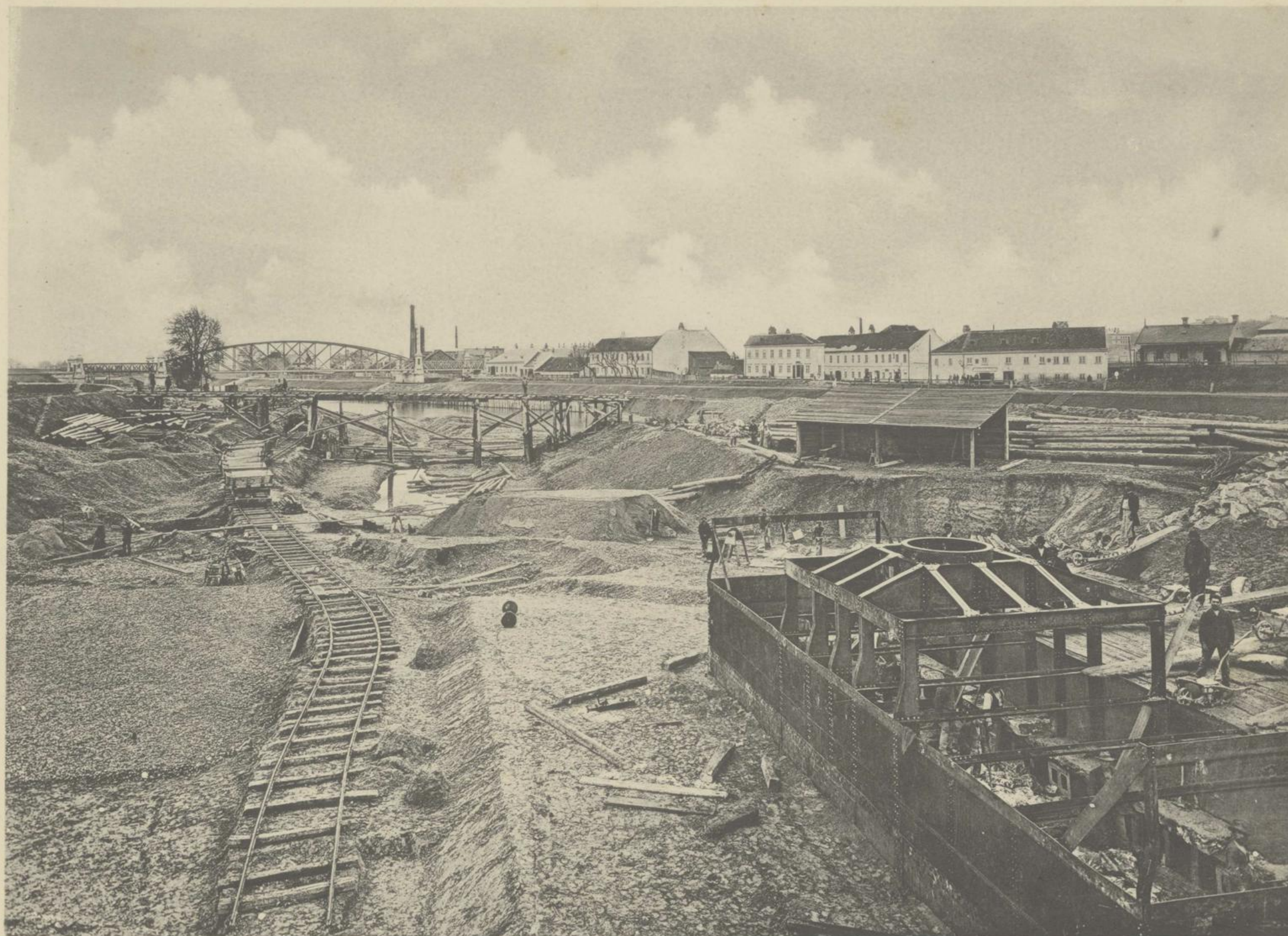
Beginn der Mauerung für die Herstellung der gemauerten Arbeitskammer des Brücken-Caissons Nr. I im Einschnitte für den unteren Theil des Schleusen-Canales. — Stand 130 m über Nullwasser.
