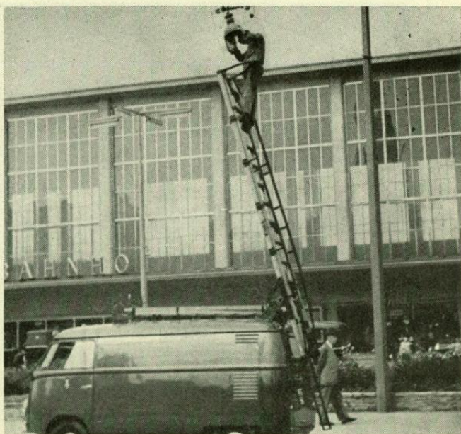
Täglich müssen im Straßenbeleuchtungsnetz zirka 255 Lampen ausgewechselt werden. Der neue Volkswagen-Transporter mit einer ausziehbaren Leiter erleichtert diese Arbeit bedeutend
