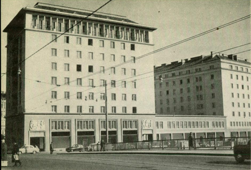
Wunderbar architektonisch gegliedert ist die städtische Wohnhausanlage in der Grederstraße
