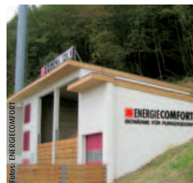
Die Biomasse-Anlagen der „ENERGIECOMFORT“ in (von oben) Bad Aussee (Steiermark), Tannheim (Tirol) und Purkersdorf bei Wien
