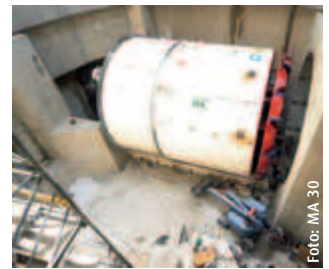
Einbau des Fräskopfs des Wiener „Bohrwurms“ in rund 30 m tiefen Startschacht
