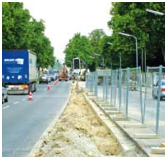
▲ Eine Lärmschutzwand entsteht ... (Juli 2009)
