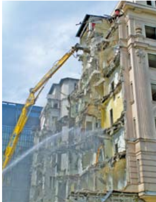
▲ Abbruch mit Berieselung gegen Staubentwicklung
