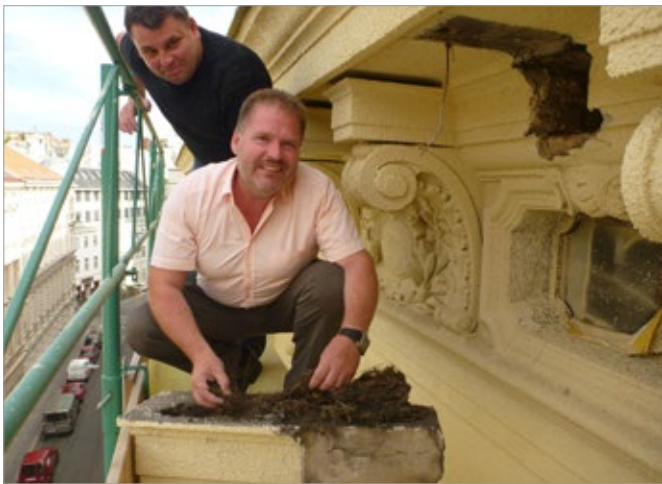
Die Geschäftsführer der Firma Kürschner Bau, Georg Szücs und Gerhard Theurer, beim Reinigen des Nistplatzes an der Hausfassade.
