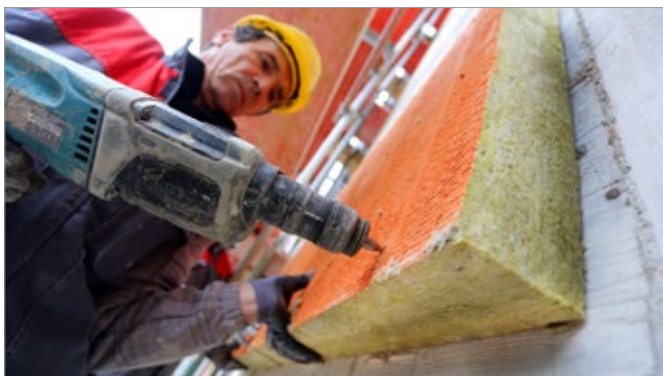
Sanierungen bringen hohe Energieeinsparung.
