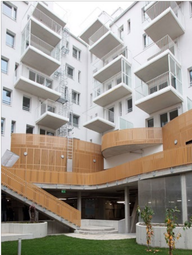
Passivhauswohnanlage in Wien 10.
