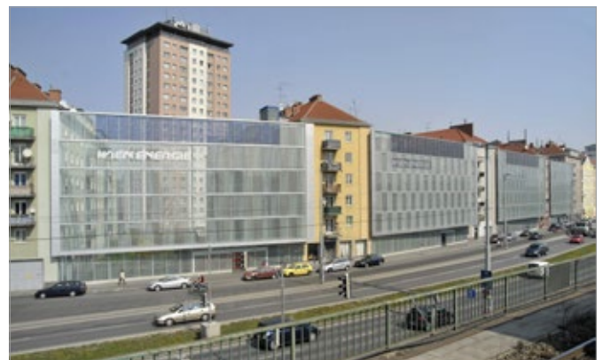
Maßnahmen zur Verbesserung.
