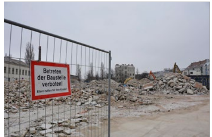
Baustellen bedeuten Feinstaubbelastung.
