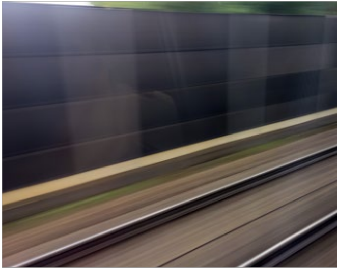
Lärmschutzwände gegen Schienenlärm.
