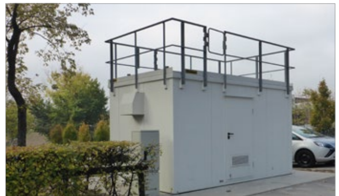
Neuer Luftmessstellenstandort: A23-Wehlistraße.
