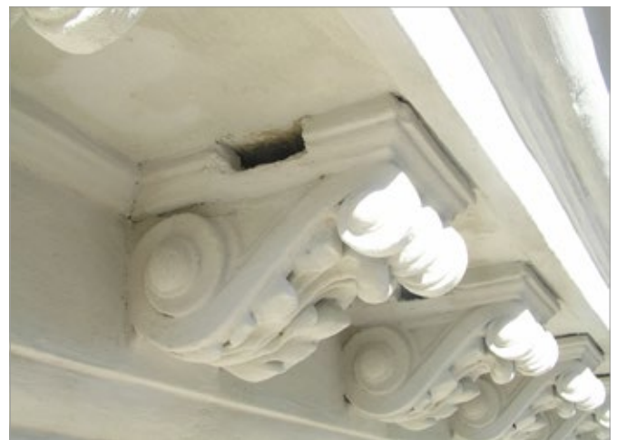
Geöffnete hohle Konsole an einer Fassade in der Kriehbergasse zur Schaffung eines Brutplatzes für den Mauersegler. Diese Lösung wird auch als das „Wiener Modell“ bezeichnet.
