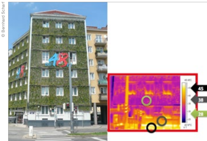
Die Thermalaufnahme zeigt die stark kühlende Wirkung der begrünten Fassade der MA 48.
