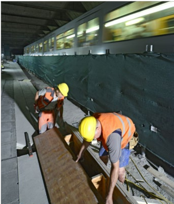
Vorbereitungsarbeiten für die Verlängerung U1 nach Süden.
