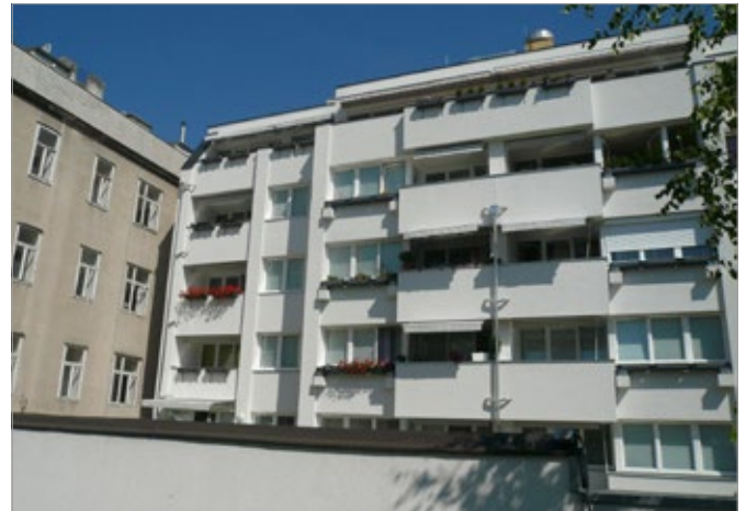
Thermisch-energetisch saniertes Wohnhaus, Sechshäuser Straße 51.
