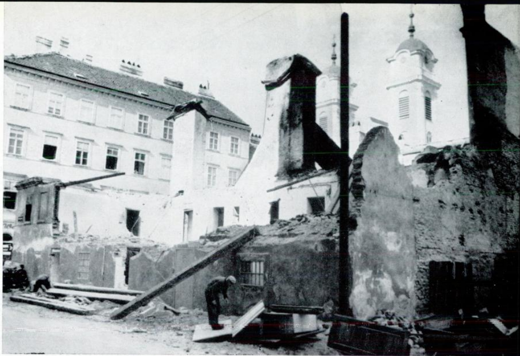
Mit der Assanierung des Schubertviertels im Lichtental wird begonnen
