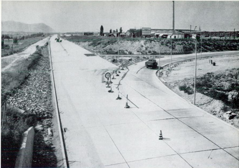
Am linken Donauufer entsteht eine Schnellstraße, die von der geplanten vierten Donaubrücke bis über die Stadtgrenze gegen Lang-Enzersdorf hinausführt
