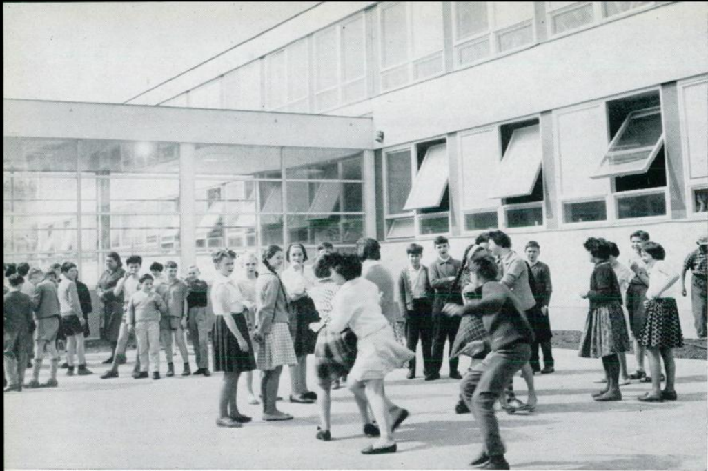
Pausenhof der neuen städtischen Volks- und Hauptschule in der Peterlinigasse, Mauer Schulwesen
