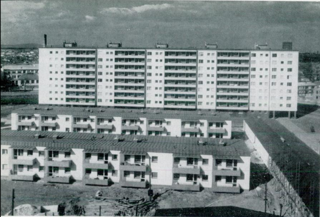
Die neue städtische Wohnhausanlage in der Offenbachgasse im 2. Bezirk
