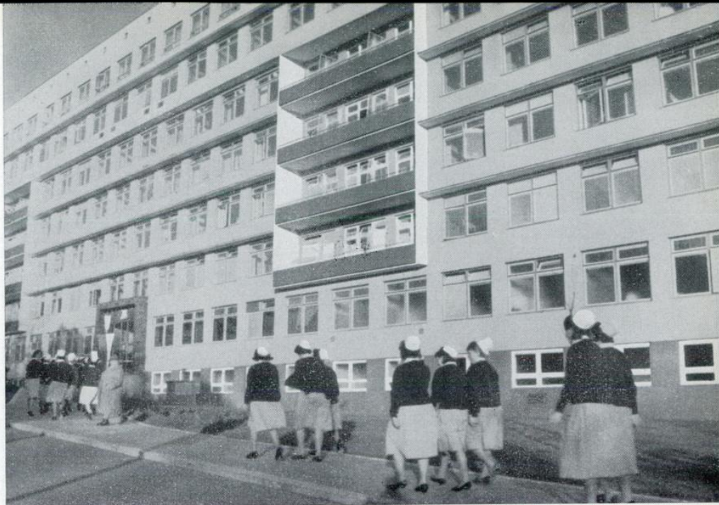
Der neue chirurgische Pavillon im Wilhelminenspital wurde in einer Bauzeit von fünf Jahren errichtet
