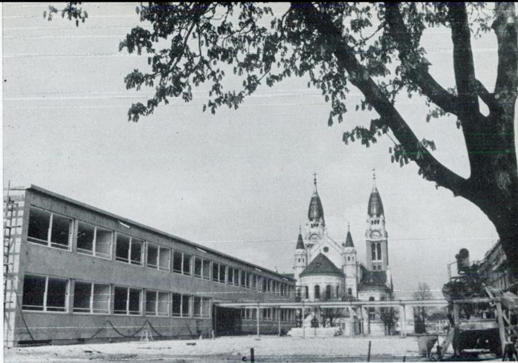
Im Zentrum des 11. Bezirkes, auf dem Enkplatz, entsteht eine moderne städtische Hauptschule
