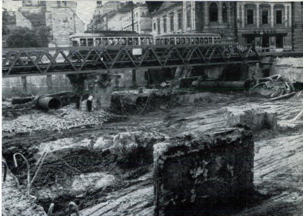
Eine von den Bundesheer-Pionieren errichtete Brücke überquert eine große Baugrube der Unterpfasterstraßenbahn
