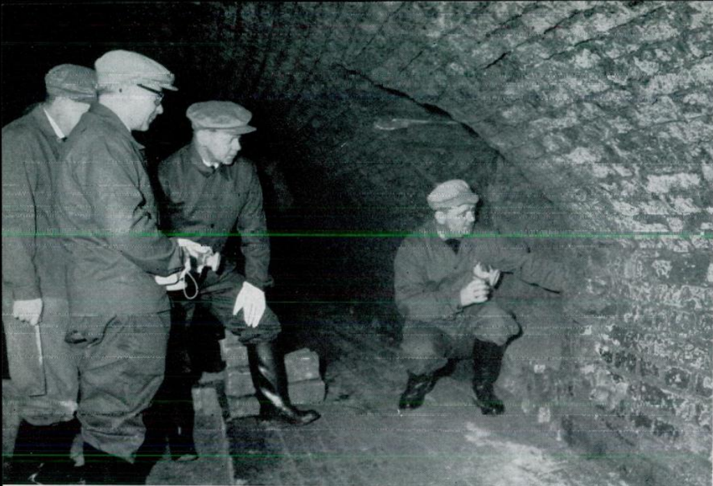
Erneuerungsarbeiten im Alserbach-Sammelkanal — Seitenwände und Sohle des mehr als 120 Jahre alten Ziegelmauerwerks müssen immer wieder ausgebessert werden
