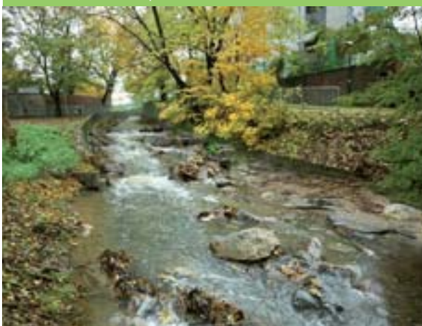
Umbau der Absturzbauwerke in eine fischpassierbare „aufgelöste Rampe“
