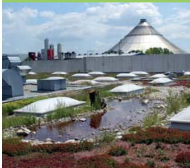
Gründach der Firma Steinbauer (Firmenstandort der ISS Grünraum) in Wien 22, Percostraße 19
