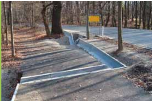
Tunnelanlage an der Exelbergstraße anno 2009
