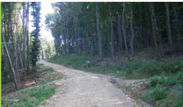
Neuanlage einer Forststraße in Wien-Hernals
