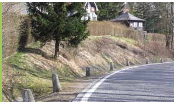
Straßenböschung an der Höhenstraße
