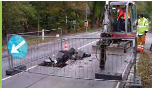
Bauarbeiten zum dritten Streckenabschnitt Exelbergstraße
