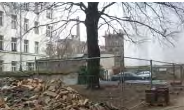
Vorbildhafte Baustelle bei der Blutbuche im 9. Bezirk, Beethoven-gasse 6–8. Es wurde eine große Schutzzone eingerichtet.
