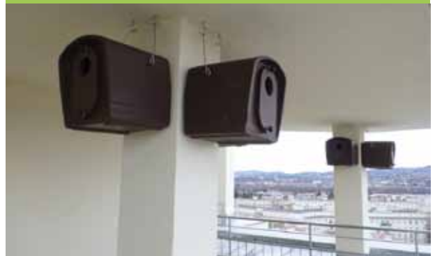
Neue Mehlschwalben-, Mauersegler- und Dohlenquartiere am „Hochhaus“ in der Pragerstraße 3
