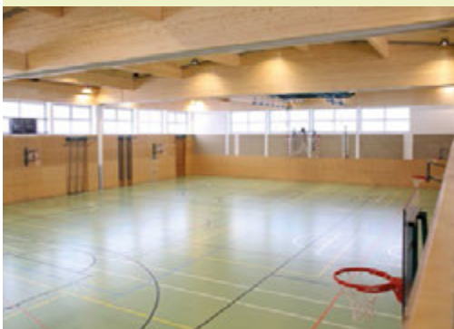
Pastorstraße (neues Dach mit LED-Beleuchtung)
