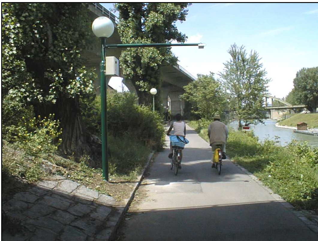
Abbildung 13: Zählstelle Donaukanalbegleitweg bei der S45-Schnellbahnbrücke
