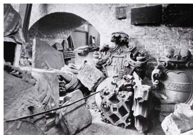
Das Steindepot im Stadtbahnbogen in der Heiligenstädter Straße (Wien 19), vor 1948. © Wien Museum
