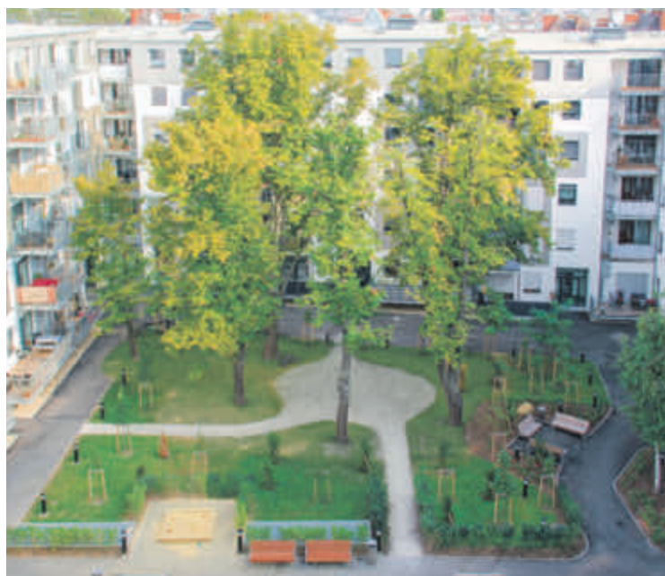
Der unter Denkmalschutz stehende Lobbmeyrhof in Ottakring wurde auch saniert.
