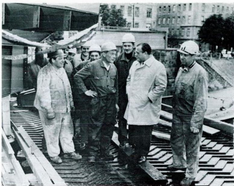
Stadtrat Kurt Heller (Tiefbau) überzeugt sich vom raschen Fortschritt der Bauarbeiten zur Verbreiterung der Friedensbrücke
