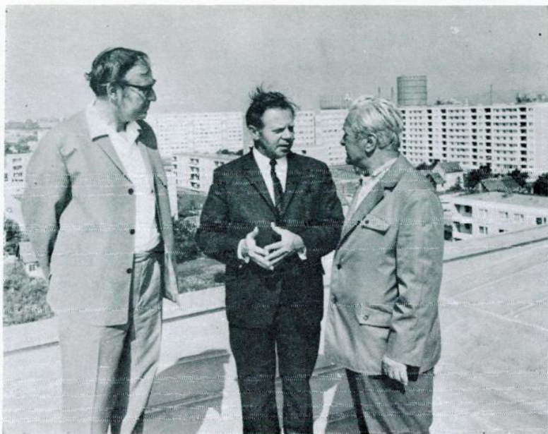
Stadtrat Hubert Pfoch (Hochbau) besichtigt die größte Baustelle des Wiener Wohnhausbaues, die Großfeldsiedlung, und informiert sich über den Fortschritt der Arbeiten
