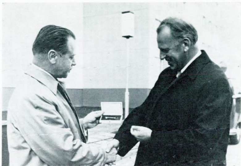
Stadtrat Reinhold Suttner (Wohnungswesen) übernimmt von Stadtrat Hubert Pfoch (Hochbau) den Schlüssel zur 10.000. „Montage-Bau“-Wohnung
