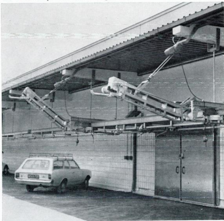
Die Verladerampe des neuen Fleischgroßmarktes mit den Förderanlagen
