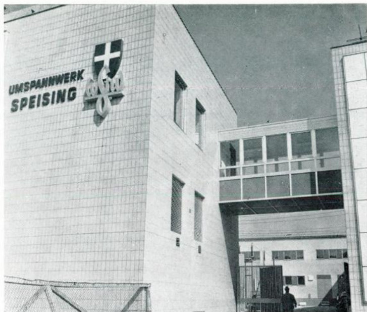
Der Bau des neuen, ferngesteuerten Umspannwerkes Speising kostete 85 Millionen Schilling
