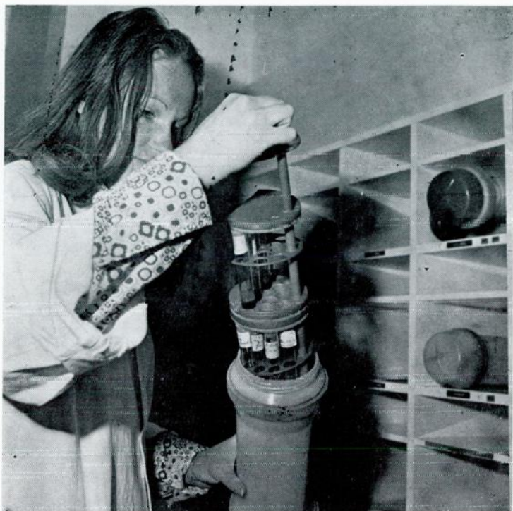
Europas größte Labor- und Befundrohrpostanlage wurde im Krankenhaus Lainz in Verwendung genommen
