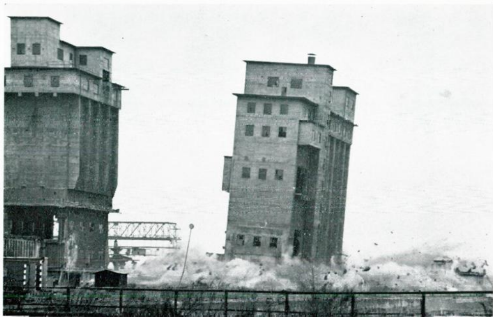
Mit der Sprengung der Kohlen-Misch- und Mahlanlage im Werk Leopoldau wurde das Kohlenzeitalter der Wiener Gaswerke beendet. Die Gaswerke liefern nur mehr Spaltgas und reines Erdgas
