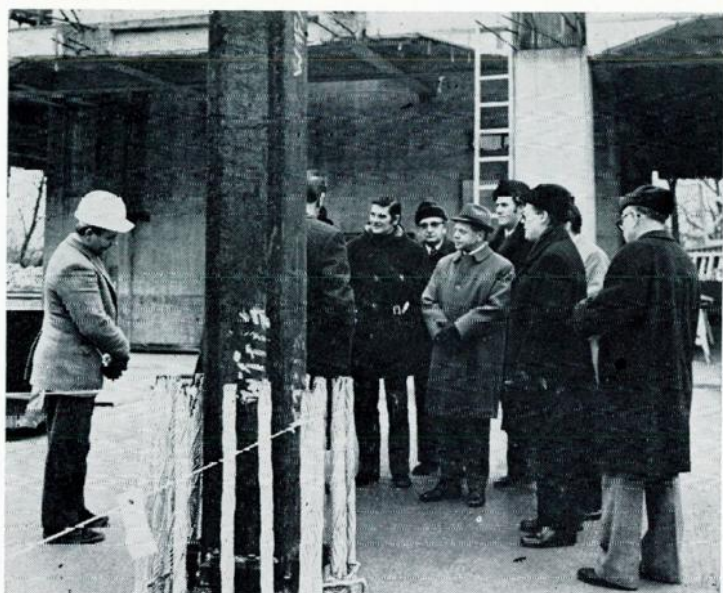
Vizebürgermeister Hubert Pfoch (Amtsf. Stadtrat für Wohnen und Liegenschaftswesen) besichtigt die Baustelle des neuen Allgemeinen Krankenhauses
