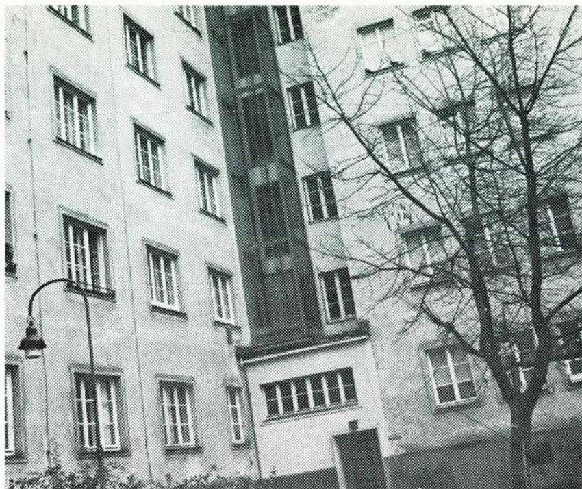
Um den Wohnwert in älteren Wohnhausanlagen zu verbessern, werden Personenaufzüge eingebaut. Im Bild: Angebauter Personenaufzug mit Stahlgerüst und Profilitverglasung
