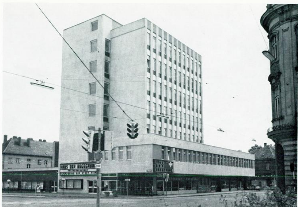
Ein neues Haus der Begegnung wurde in Liesing im 23. Bezirk, Perchtoldsdorfer Straße 1, gebaut
