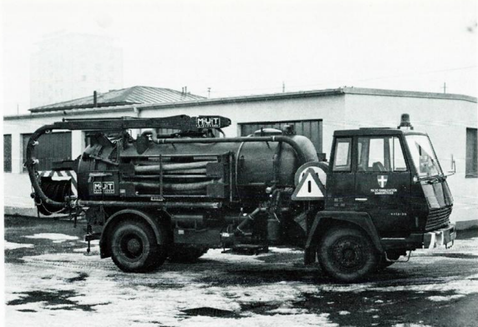
Neues Einsatzfahrzeug des Kanalbetriebes mit Absaugvorrichtung für die Reinigung von Kanälen und Senkgruben
