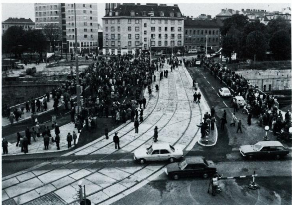
Die neue Philadelphiabrücke kurz vor der Eröffnung
