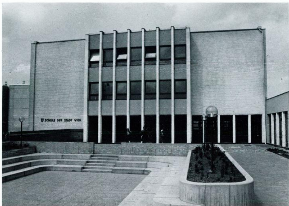
Eine zwölfklassige Volksschule wurde im 22. Bezirk, Aderklaaer Straße 4, gebaut
