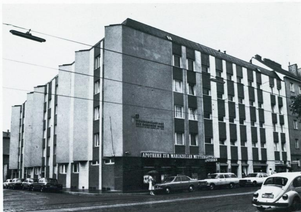
Wohnhausanlage der Gemeinde Wien im 21. Bezirk, Donaufelder Straße 22
