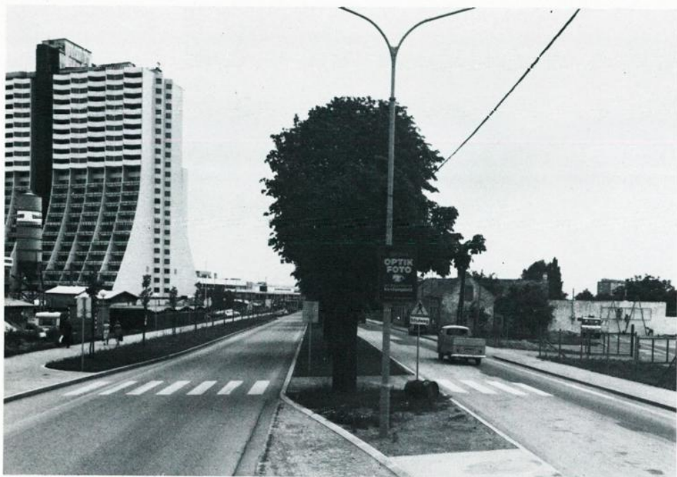
Die Anton Baumgartner-Straße im 23. Bezirk wurde im Bereich des Wohnparkes Alt Erlaa verbreitert Straßenbau
