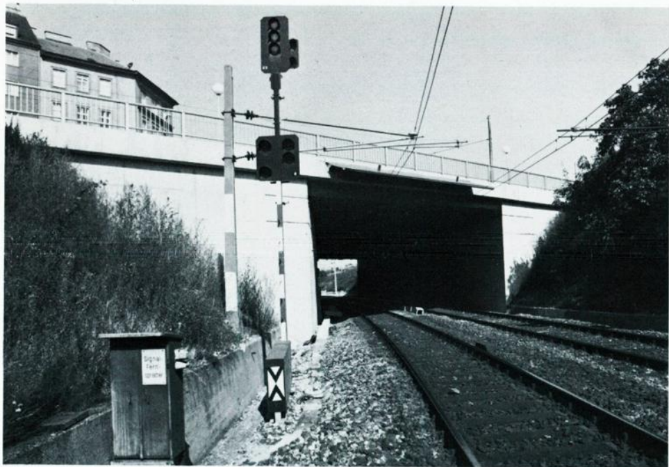
Die neue Landstraßer Gürtelbrücke über die Schnellbahn konnte nach eineinhalbjähriger Bauzeit fertiggestellt werden
