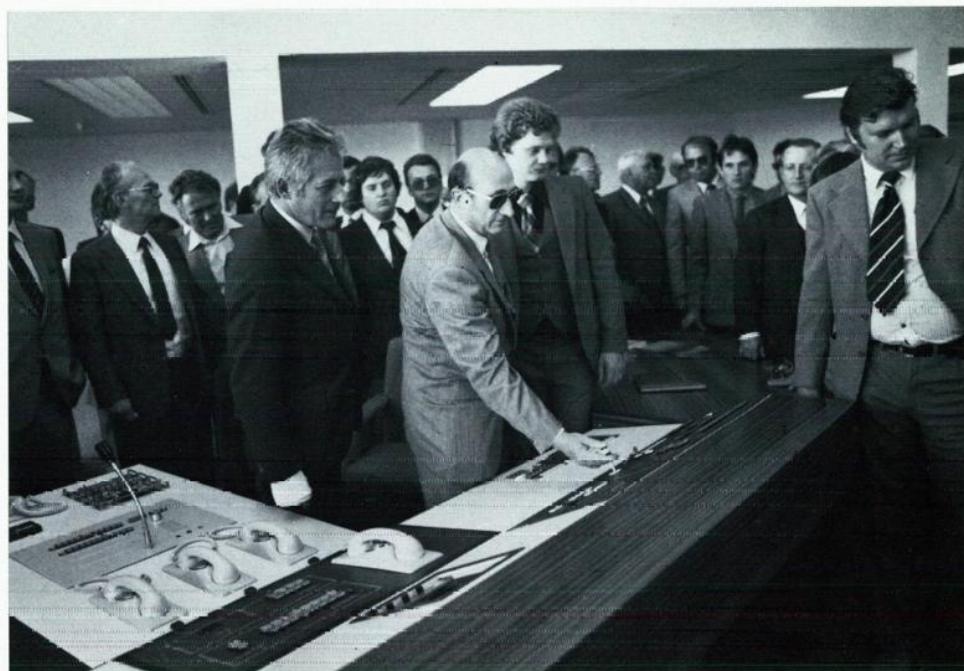
Bürgermeister Leopold Gratz und Amtsführender Stadtrat Josef Veleta bei der Inbetriebnahme der Hauptkläranlage Kaiserebersdorf
