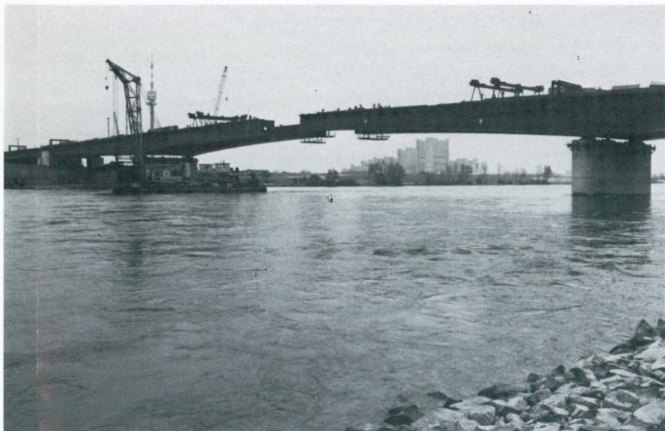
Zusammenschluß der Brigittenauer Brücke über dem Donaustrom
