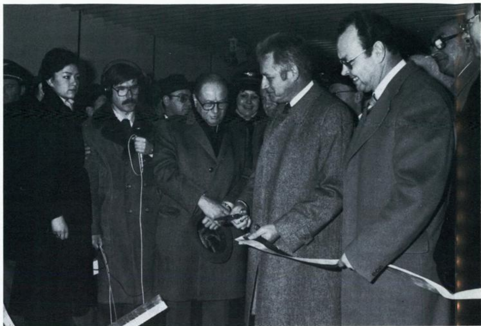
Bundeskanzler Dr. Bruno Kreisky, Bürgermeister Leopold Gratz und Amtsführender Stadtrat Heinz Nittel † (Straße, Verkehr und Energie) bei der Eröffnung des neuen U-Bahn-Abschnittes Nestroyplatz – Praterstern
