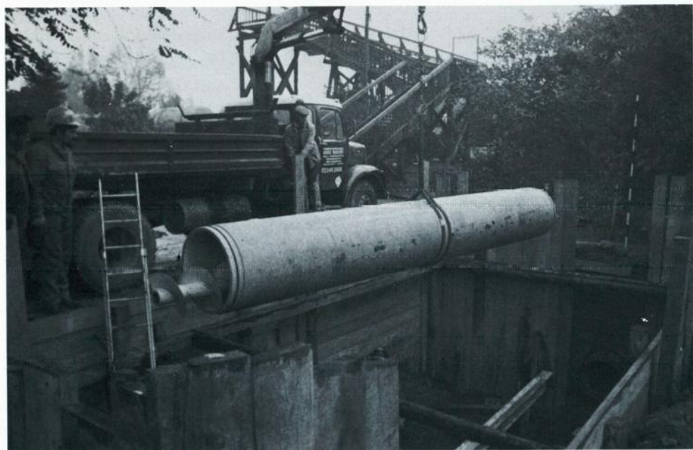
Gasrohrpressung im 11. Bezirk, Kaiserebersdorfer Straße
