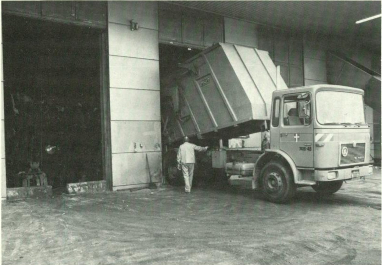
Müllentleerung in der Sondermüllverbrennungsanlage der Entsorgungsbetriebe Simmering
