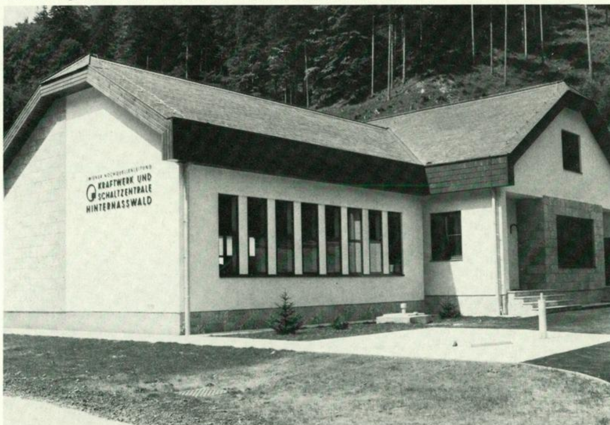
Das Betriebsgebäude des Kraftwerkes und der Schaltzentrale Hinternaßwald
