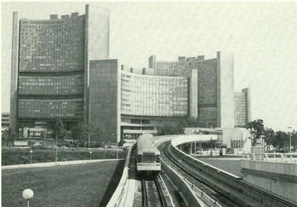
Mit der Verlängerung der U-Bahn-Linie U 1 um rund vier Kilometer vom Praterstern bis zum Zentrum Kagran ist die erste Ausbauphase des Wiener U-Bahn-Netzes abgeschlossen. Im Bild die Hochstrecke der Linie U 1 bei der Station Kaisermühlen – Vienna International Centre
