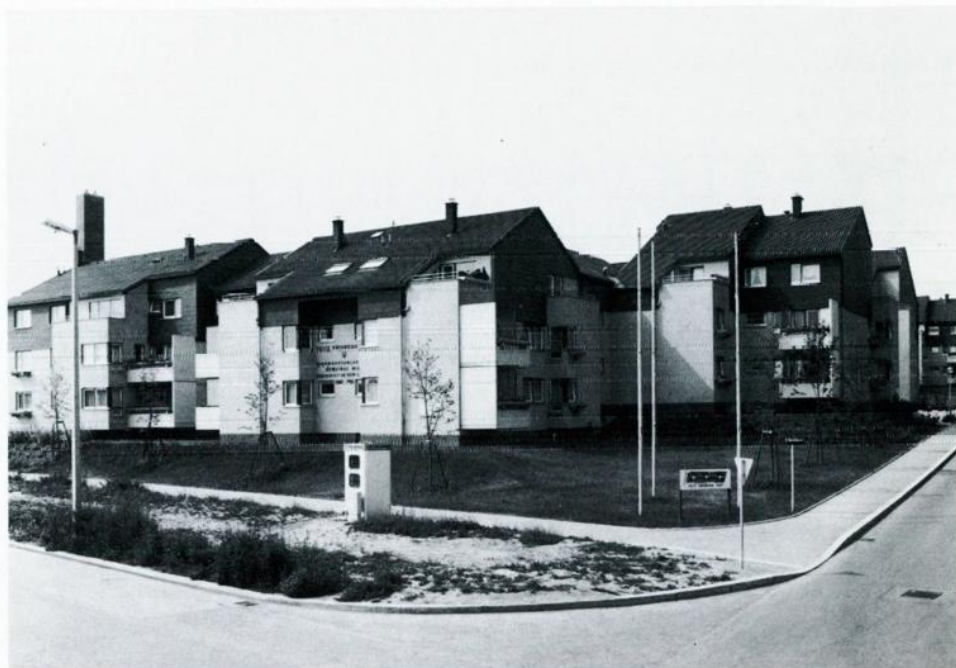
Die neuerrichtete städtische Wohnhausanlage im 11. Bezirk, Schemmerlstraße – Mitterfeldgasse
