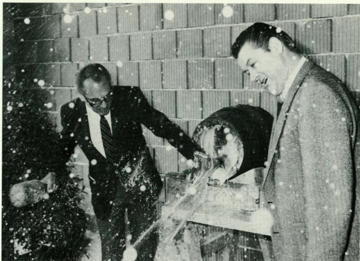
Dachgleichenfeier für die Volksschule Gerhardusgasse mit Stadtrat Roman Rautner
