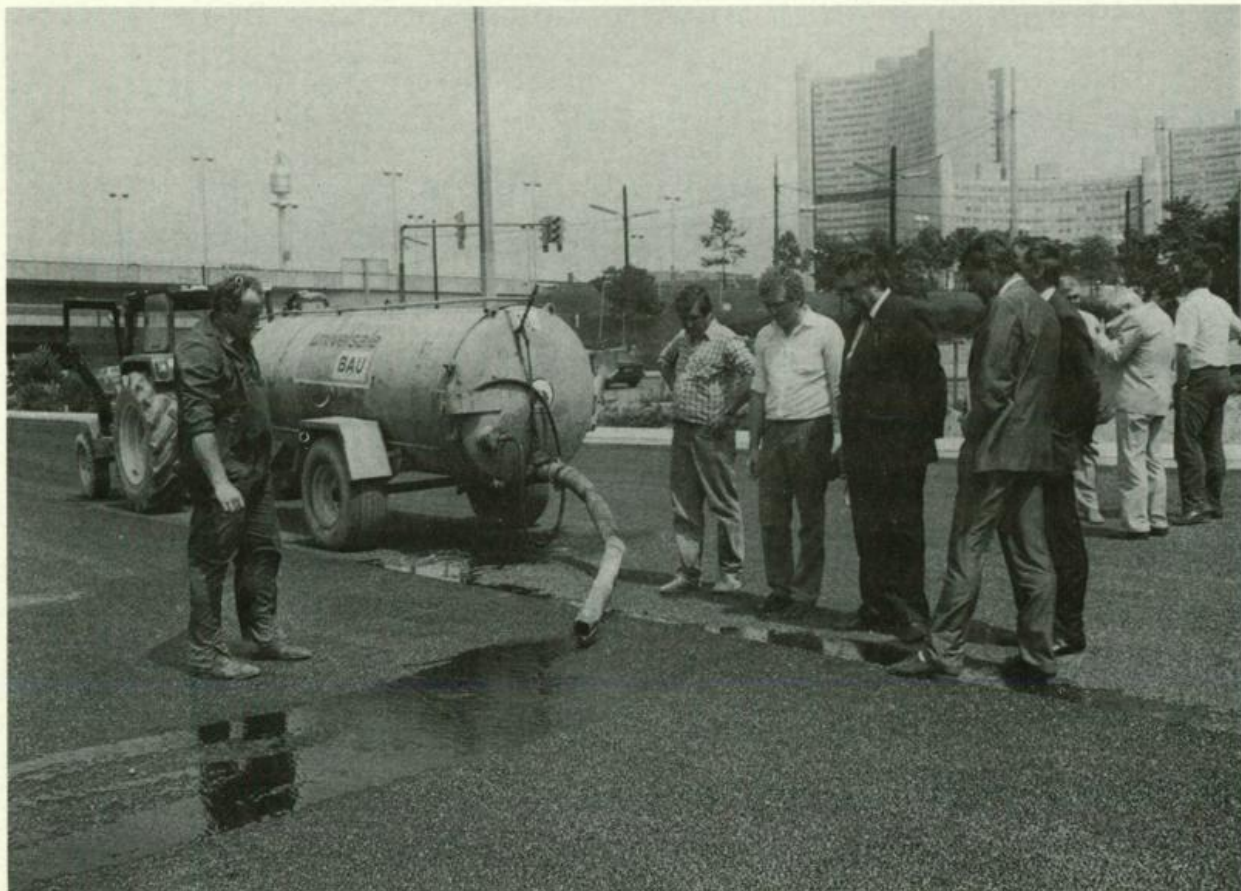
Belagsarbeiten auf der Donauufer-Autobahn
