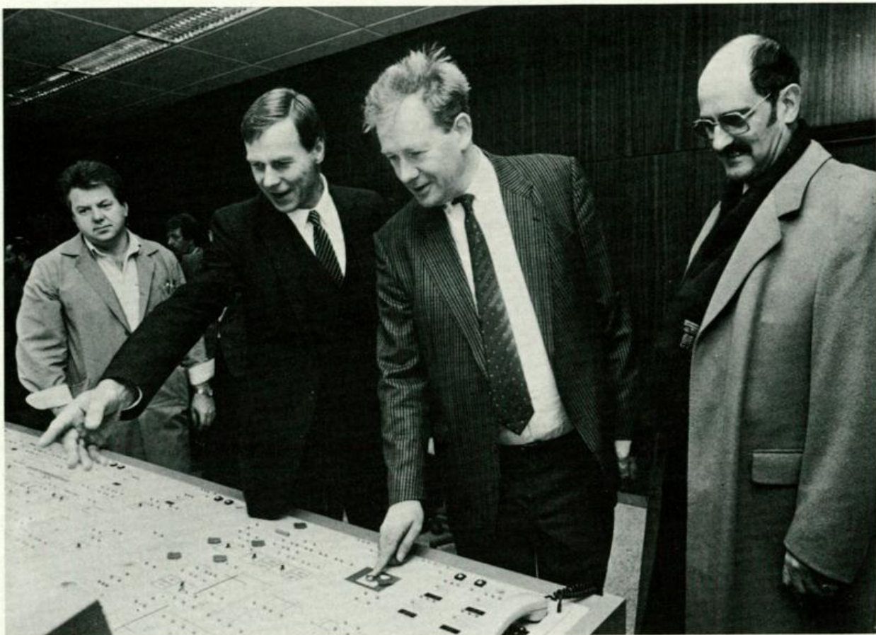
Inbetriebnahme der neuen Gasturbine im Kraftwerk Leopoldau durch den Amtsführenden Stadtrat für Verkehr und Energie Johann Hatzl
