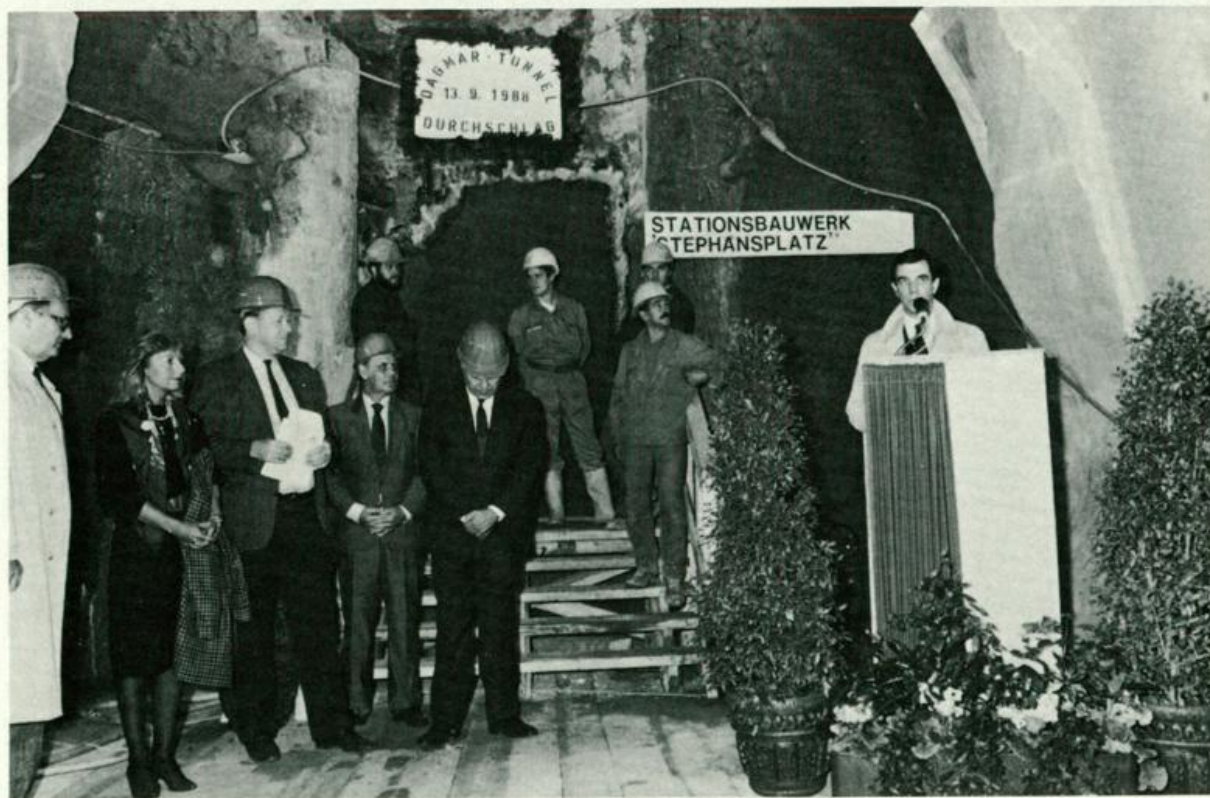
Tunneldurchschlag der U3, Abschnitt Herrengasse
