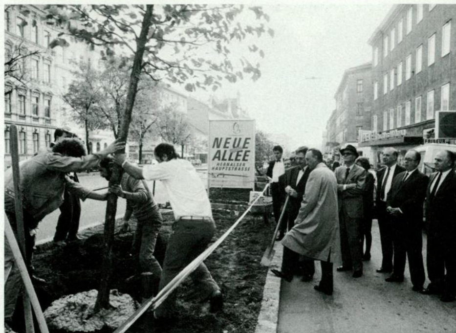
Erste Baumsetzung für die Allee in der Hernalser Hauptstraße
