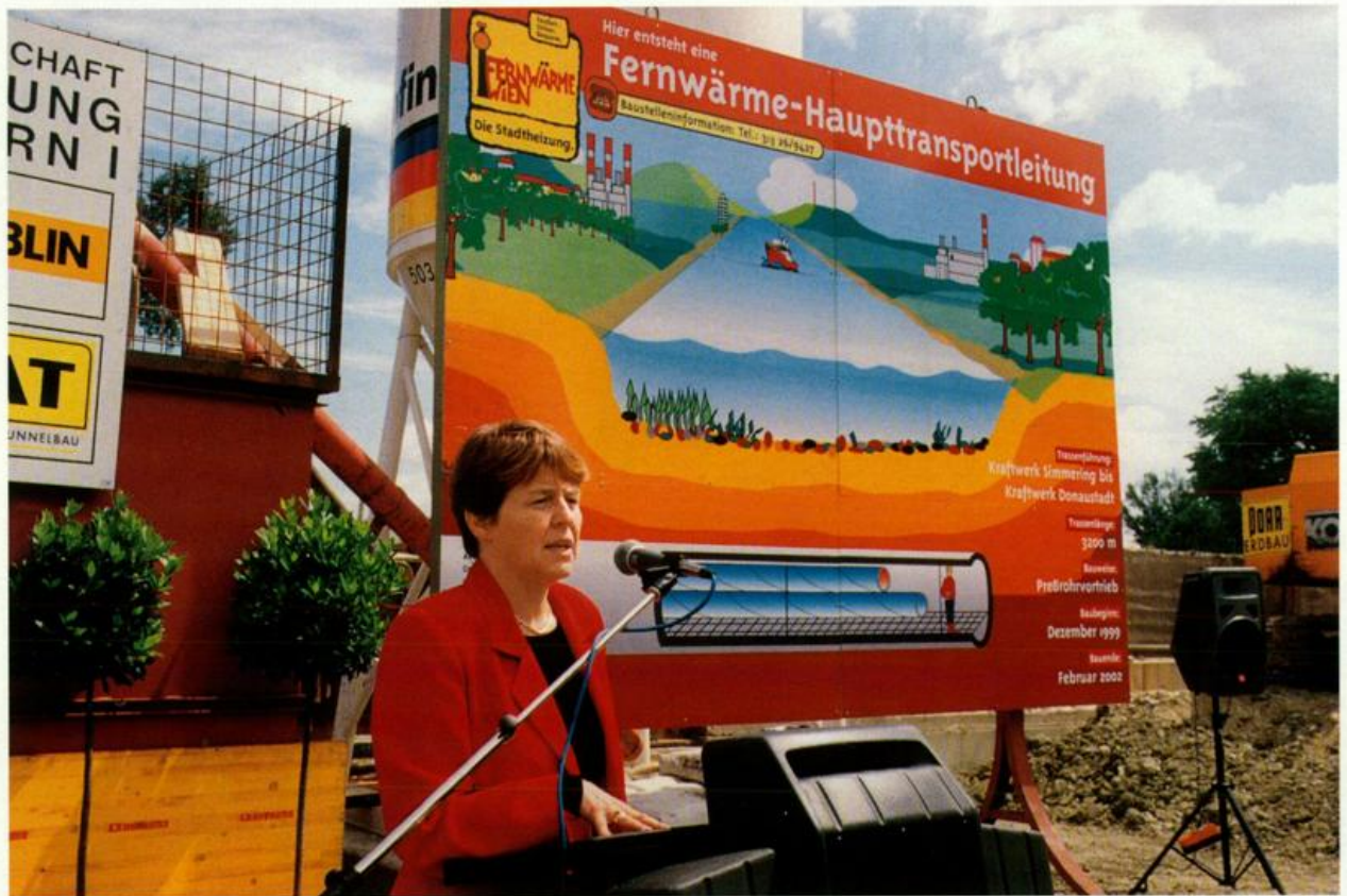
Im Frühjahr 2000 erfolgte der Tunnelanstich für die neue Fernwärme-Haupttransportleitung unter der Donau zwischen den Kraftwerken Simmering und Donaustadt.
