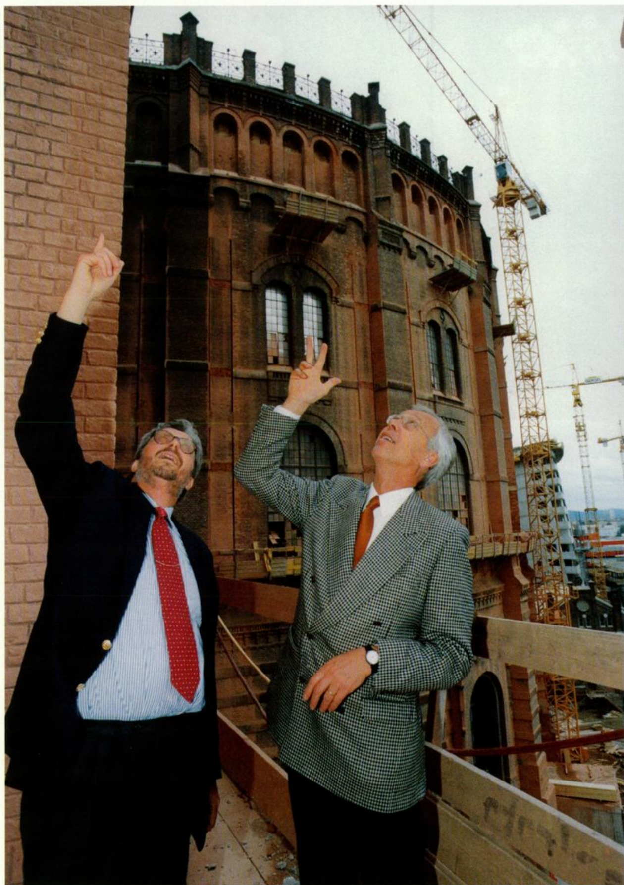
Archivdirektor Dr. Ferdinand Opl und Kulturstadtrat Dr. Peter Marboe besichtigen die Baustelle des zukünftigen Wiener Stadt- und Landesarchivs im Gasometer D anlässlich der Gleichenfier.
