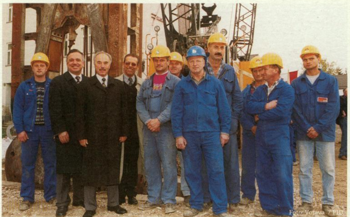
Am 29. Oktober 2001 erfolgte der Baubeginn zur Verlängerung der U-Bahnlinie U1 von Kagran nach Leopoldau.
