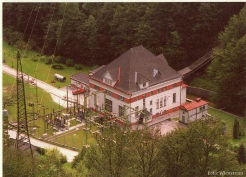
Das Kleinwasserkraftwerk Gaming 1 nutzt als Ökoenergieanlage das Wasser der II. Wiener Hochquellenleitung.
