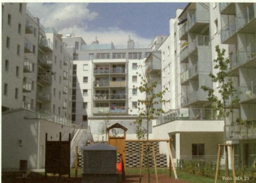
Die MA 25 trägt durch ihre Prüftätigkeit maßgeblich zur Schaffung von neuem, sozial leistbarem Wohnraum bei. Hier als Beispiel ein Objekt in 21., Fultonstraße.
