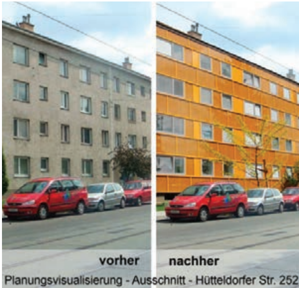
Die Photovoltaikmodule, die an der Außenverglasung eingesetzt werden, sind so ausgelegt, dass damit der Jahresbedarf der allgemeinen Bereiche der Wohnhausanlage sowie der Komfortlüftungsanlage gedeckt werden können. © BOKU/ Prof. Treberspurg
